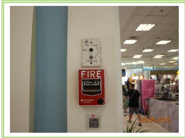
รูปที่ 2.7-1 สวิตช์กดแจ้งเหตุด้วยมือ (Fire Alarm manual Station)
