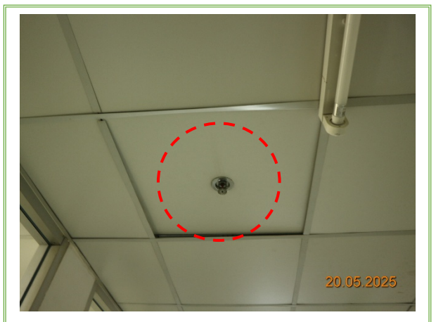
รูปที่ 3-46 ระบบหัวกระจายน้ำดับเพลิงอัตโนมัติ
